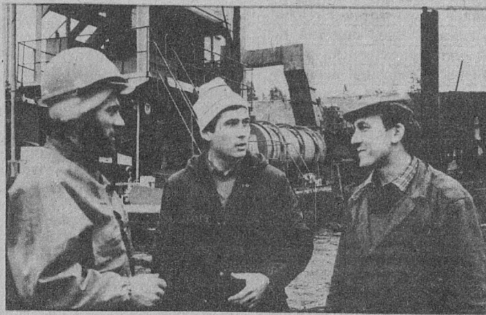
Асфальтобетонный завод — основной поставщик асфальтобетона и обогащенного мастикой рубероида для всех строительных объектов города. Немногочисленный его коллектив успешно справляется со своими обязанностями, ежемесячно выполняя нормы выработки на 130—140 процентов. НА СНИМКЕ (слева направо): оператор асфальтобетонной установки А. В. Рязанов, начальник цеха АБЗ Г. В. Касаткин, оператор Ю. В. Ларионов. Фото Г. Сафонова
