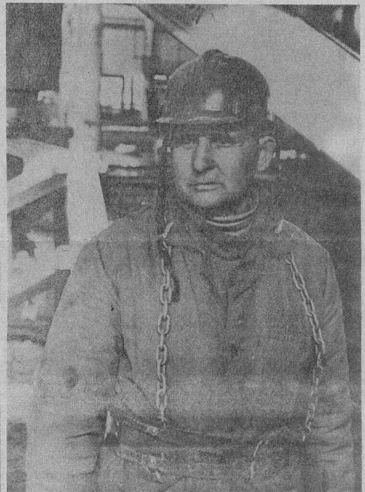
Петр Алексеевич Пашов — слесарь-монтажник из бригады В. Ф. Рыжикова монтажного управления № 90, звеньевой. Бригада ведет монтаж металлоконструкций третьего корпуса машиностроительного завода. С 1 марта она взяла подряд и успешно его выполняет. Бригада выполняет практически любые работы, монтирует оборудование котельных, конвейеров, подъемных кранов. И всегда — без брака. Среди более молодых коллег Петр Алексеевич выделяется своим опытом, стажем. Он ветеран Великой Отечественной войны, но до сих пор успешно трудится в монтажном управлении — с 1970 года. Он специалист высокого класса, имеет несколько смежных профессий — газорезчик, стропаль, электробедник, электросварщик. Знания, опыт, добросовестность — эти качества помогают П. А. Пашову исполнять и общественную нагрузку — он инспектор по технике безопасности, осуществляет первую ступень контроля за созданием безопасных условий труда для всех членов бригады.
