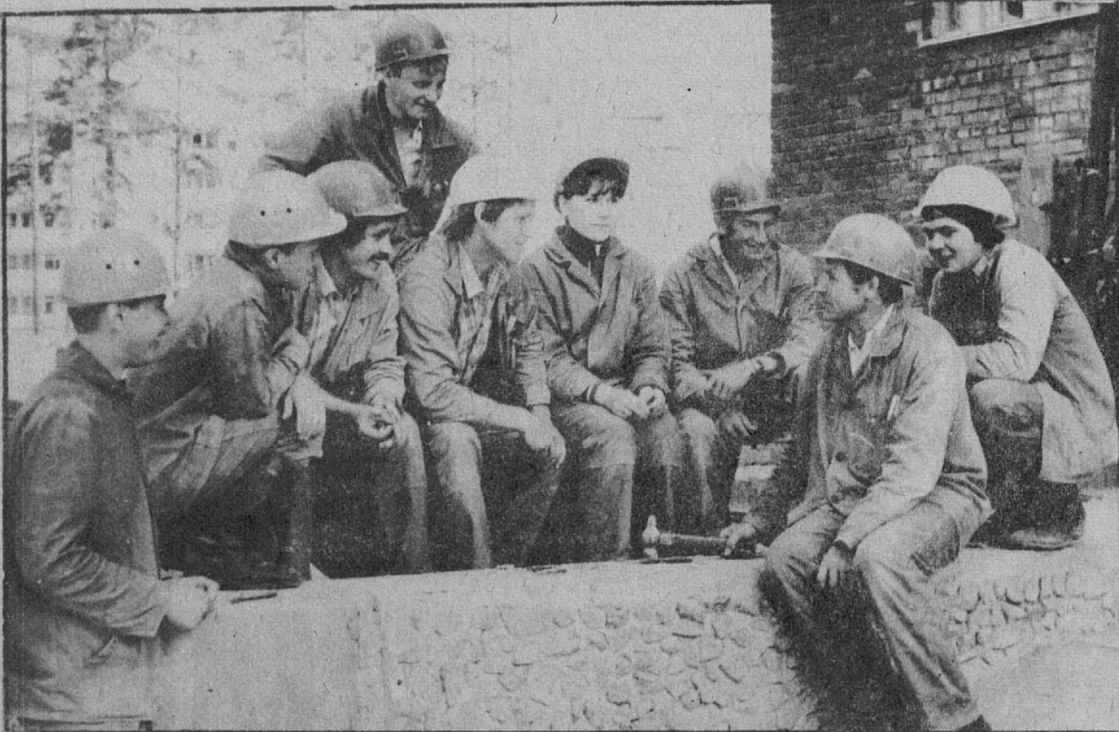
Комсомольско-молодежный коллектив электромонтажников монтажно-строительного управления № 32, созданный в 1974 году, уже через четыре года ударным трудом завоевала почетное звание бригады имени 60-летия ВЛКСМ. Ее бессменный бригадир Владимир Николаевич Иванов работает в МСУ с самого начала строительства ЛАЭС. На своего бригадира-орденоносца, члена
