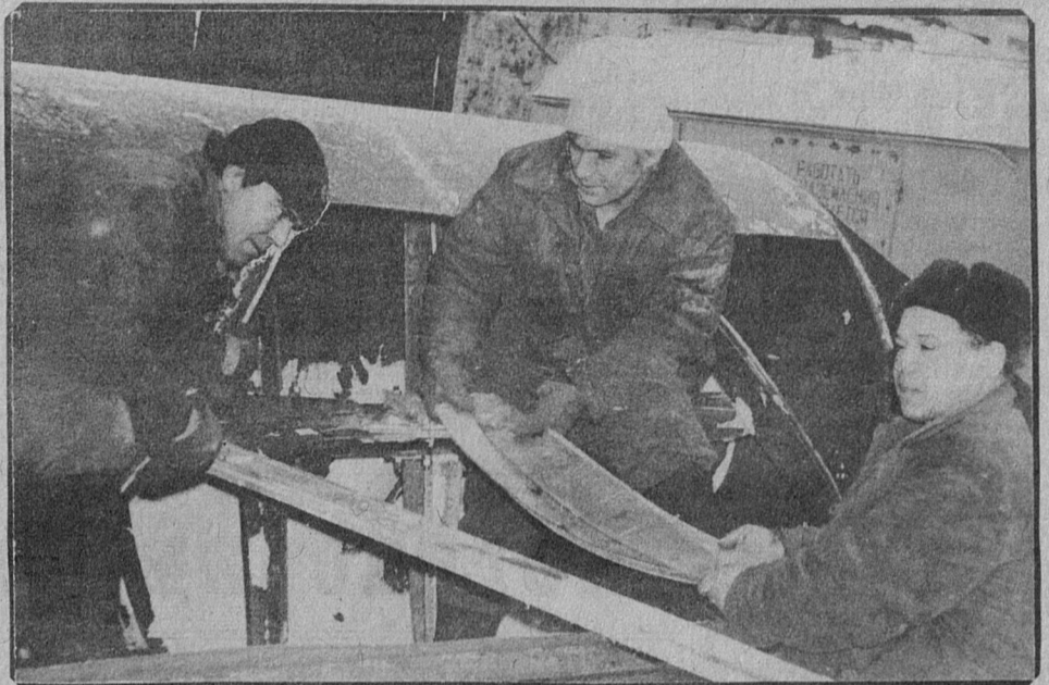
К ТОМУ, что на строительных площадках «прописались» штукатурные станции, можно сказать, привыкли. Станция жестких растворов — пока новинка. Экспериментальные образцы — первые пять штук — изготовлены для строек нашего города и Ленинграда в управлении энергообеспечения СУС. Станции предназначены для подачи жестких растворов по шлангам на требуемую высоту, в частности, на перекрытия между этажами. Изготовлением экспериментальной новой техники для стройки занимается передовая бригада Ю. Е. Кирьянова. На снимке вы видите бригадира с его товарищами, слесарями пятого разряда Ю. И. Масленниковым (слева) и В. Г. Олехновичем (справа).
