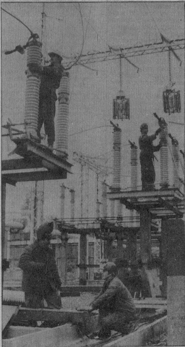
На месяц раньше срока завершили электромонтажники МСУ-32 строительство и монтаж линии электропередач напряжением 110 киловольт (фото сверху). Сооружение главной артерии электроснабжения бойлерной районного теплоснабжения продолжалось более полутора лет. Досрочная ее сдача заказчику под наладку к Дню Конституции СССР предусматривалась принятыми бригадой А. В. Рыбакова социалистическими обязательствами, с которыми она с честью справилась. Держит слово и сварщики МУ-90, которыми руководит П. Н. Павлов (фото внизу). Включившись в социалистическое соревнование по достижению 70-летия Великого Октября, бригада работает уже в счет января будущего года.
