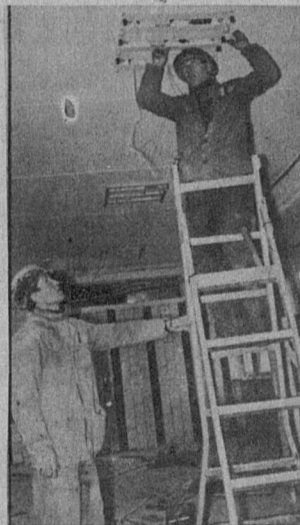
На снимках: общий вид новой столовой; электромонтажники из МСУ-32 В. А. Кузнецов и С. Н. Арбузов устанавливают светильники; рабочие бригады А. Н. Киселева (МСУ-90) ведут монтаж вентиляционных систем.
