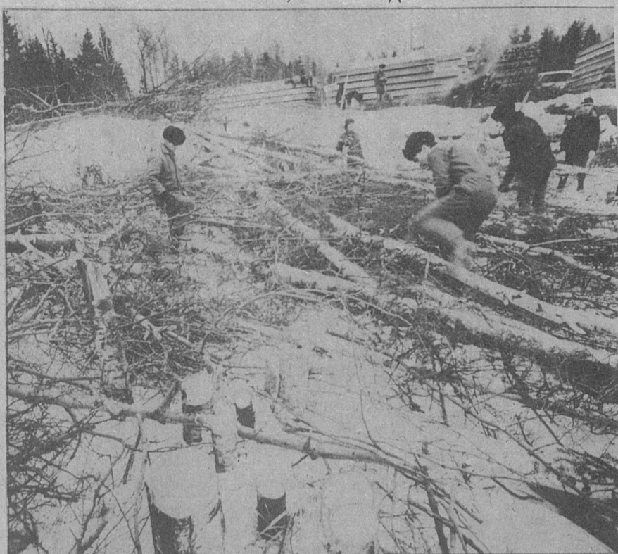
В 106 микрорайоне, неподалеку от строящейся школы № 7 с каждой неделей все отчетливее обозначаются очертания новой строительной площадки. По субботам и воскресеньям сюда приходит молодежь — кандидаты в бойцы комсомольско-молодежного строительного отряда МЖК. В эти дни они ведут рубку леса под первый дом молодежного жилого комплекса.
