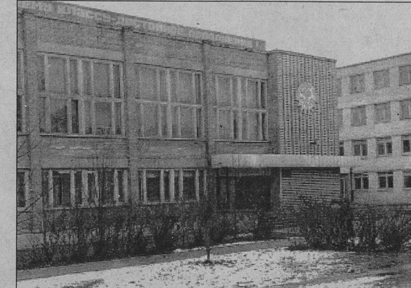
На снимке: комплекс СПТУ-236.
