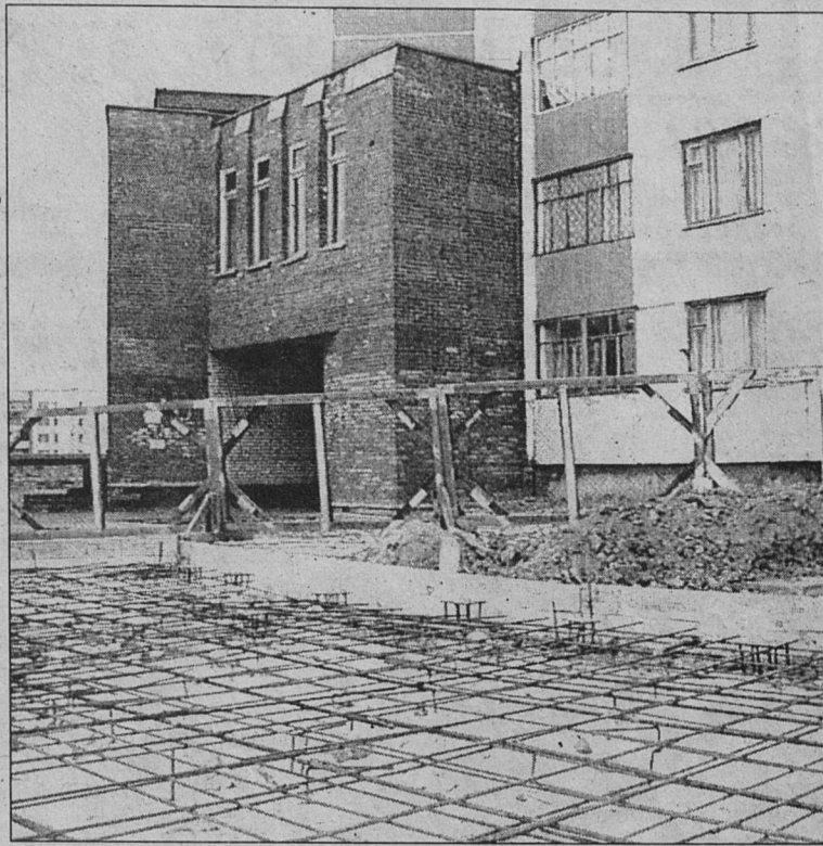
На снимке: строительство магазина началось
