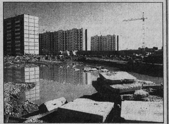
На снимках: первый бетон в фундаментную плиту будущего жилого дома укладывают работники СМУ УПП; так выглядит сегодня котлован, вырытый полтора года назад работниками СМУ ЛАЭС. Фото Ю. Шестернина
