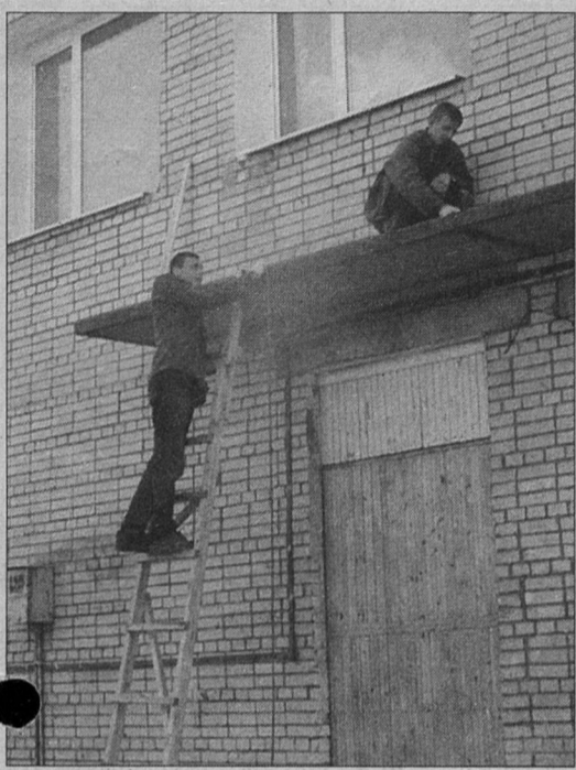
Д. Грубов (слева) и А. Маров работают на фасаде здания
